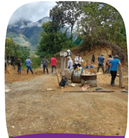
Obra en ejecución
